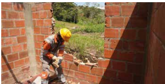
Demolición manual
